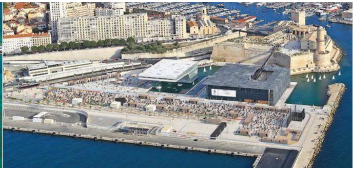
Les installations au sol
